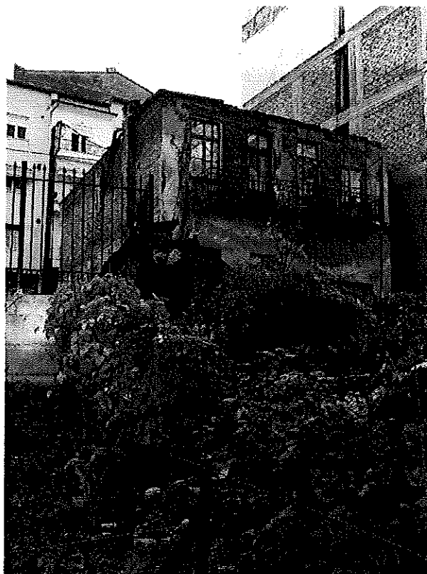
Φωτ. 2 Όψη του βοηθητικού κτίσματος - στεγάστρου
